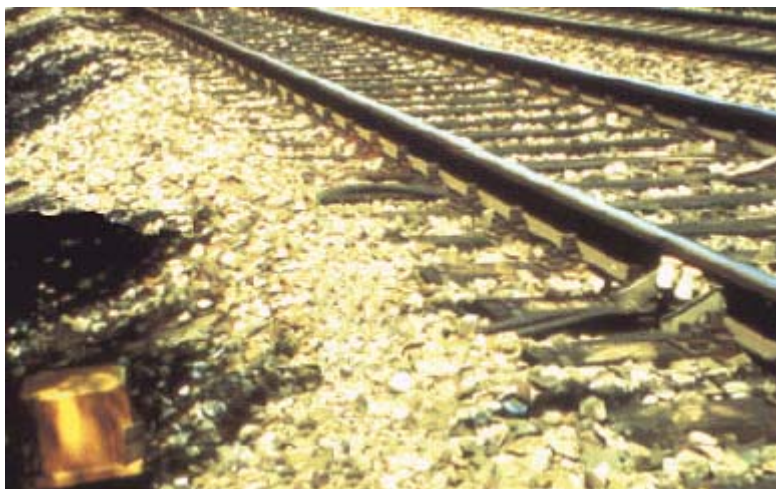
Figura 14 – Sistema de Contador de Eixos Instalado na Via
