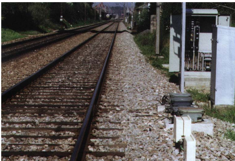
Figura 7 – Circuito de Via ITE
