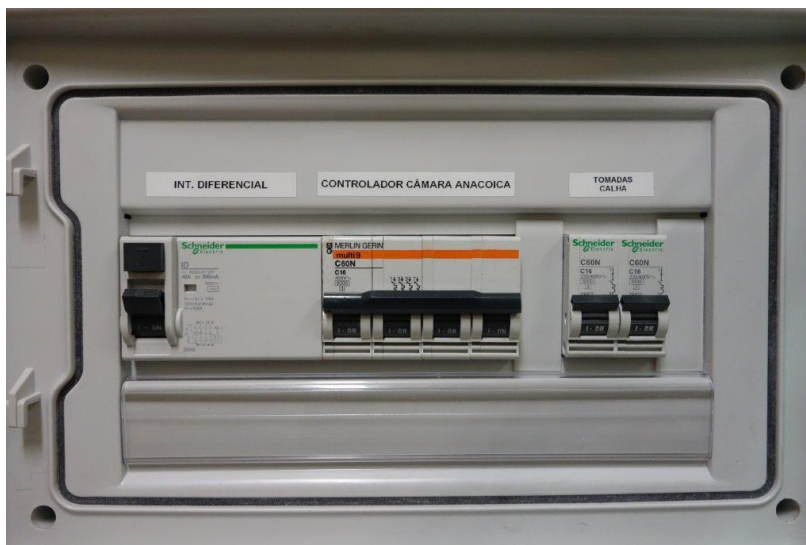
Figura 5 – a) Disjuntores b) Botão de ativação do controlador
